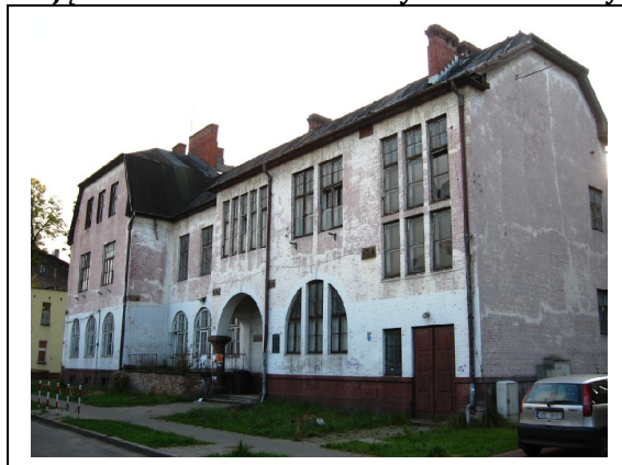
Zdjęcia 1 i 2. Zniszczone budynki oraz tereny
