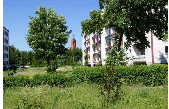
Zabudowa przy ulicy Powstańców Śl. widok na kościół p.w. Św. Mateusza Apostoła
