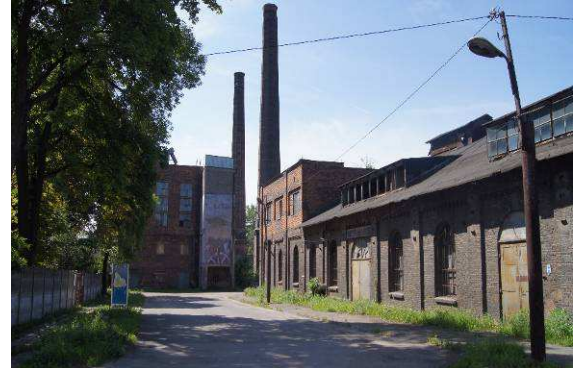
Kominy kopalniane dawnej kopalni „Saturn” obok budynku kotłowni, z zachowanym murałem na frontowej ścianie
