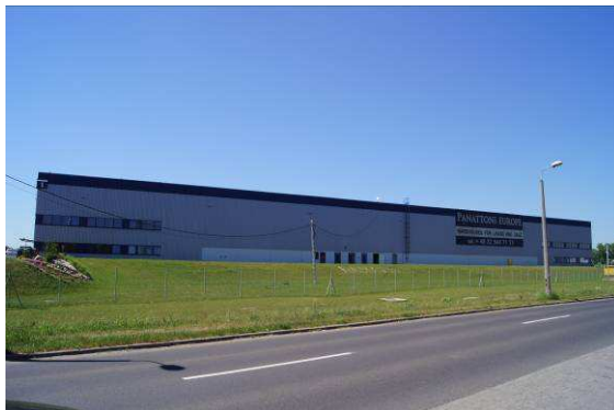
Magazyny firmy „Panattoni” przy ulicy Handlowej
