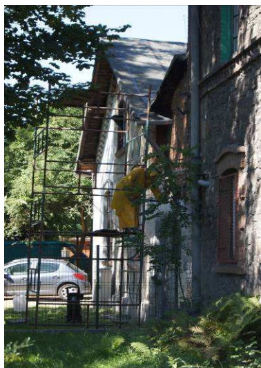
Renowacja zabytkowego budynku mieszkalnego przy ulicy Kościuszki
