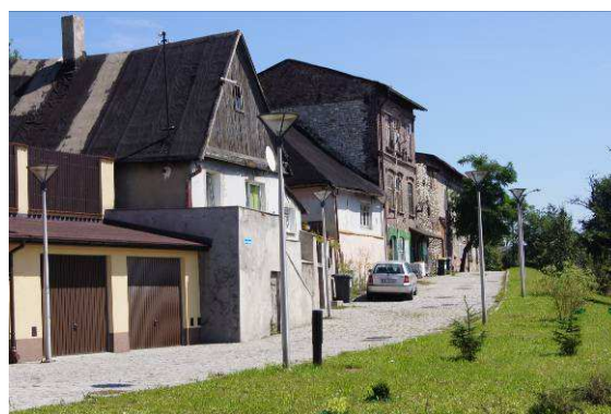
Zabudowa przy ulicy Ciasnej
