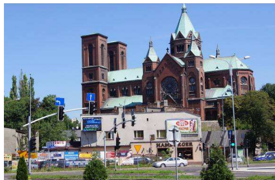
Zabudowa przy skrzyżowaniu ulic S. Staszica i 1 Maja
