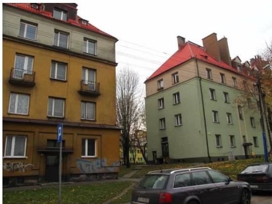
Zdjęcie 8. Zabudowa mieszkaniowa na Nowym Mieście
