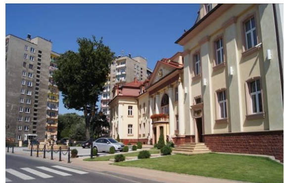
Budynek Dyrekcji dawnej kopalni „Saturn” – obecnie hotel i centrum SPA „Pałac Saturna” przy ulicy Dehnelów
