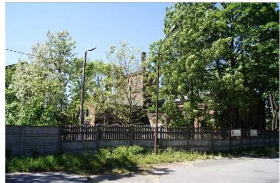
Budynek elektrowni dawnej kopalni „Saturn” – obecnie Galeria Sztuki Współczesnej „Elektrownia” przy ulicy Dehnelów
