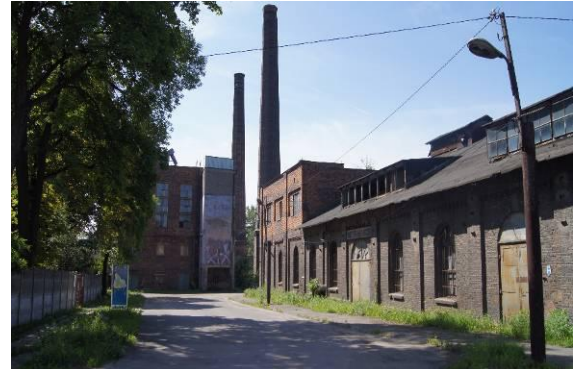
Kominy kopalniane dawnej kopalni „Saturn” obok budynku kotłowni, z zachowanym muralem na frontowej ścianie
