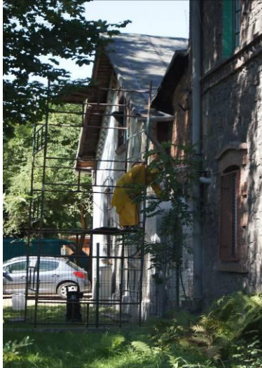
Renowacja zabytkowego budynku mieszkalnego przy ulicy Kościuszki
