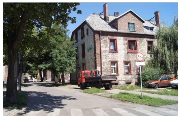
Zabytkowe budynki mieszkalne przy ulicy Warszawskiej
