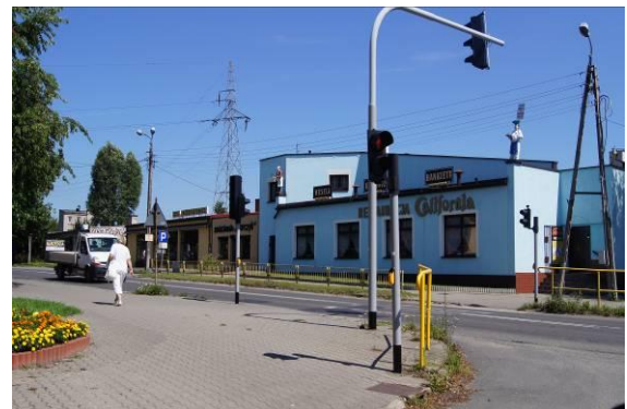
Restauracja przy ulicy Nowopogońskiej
