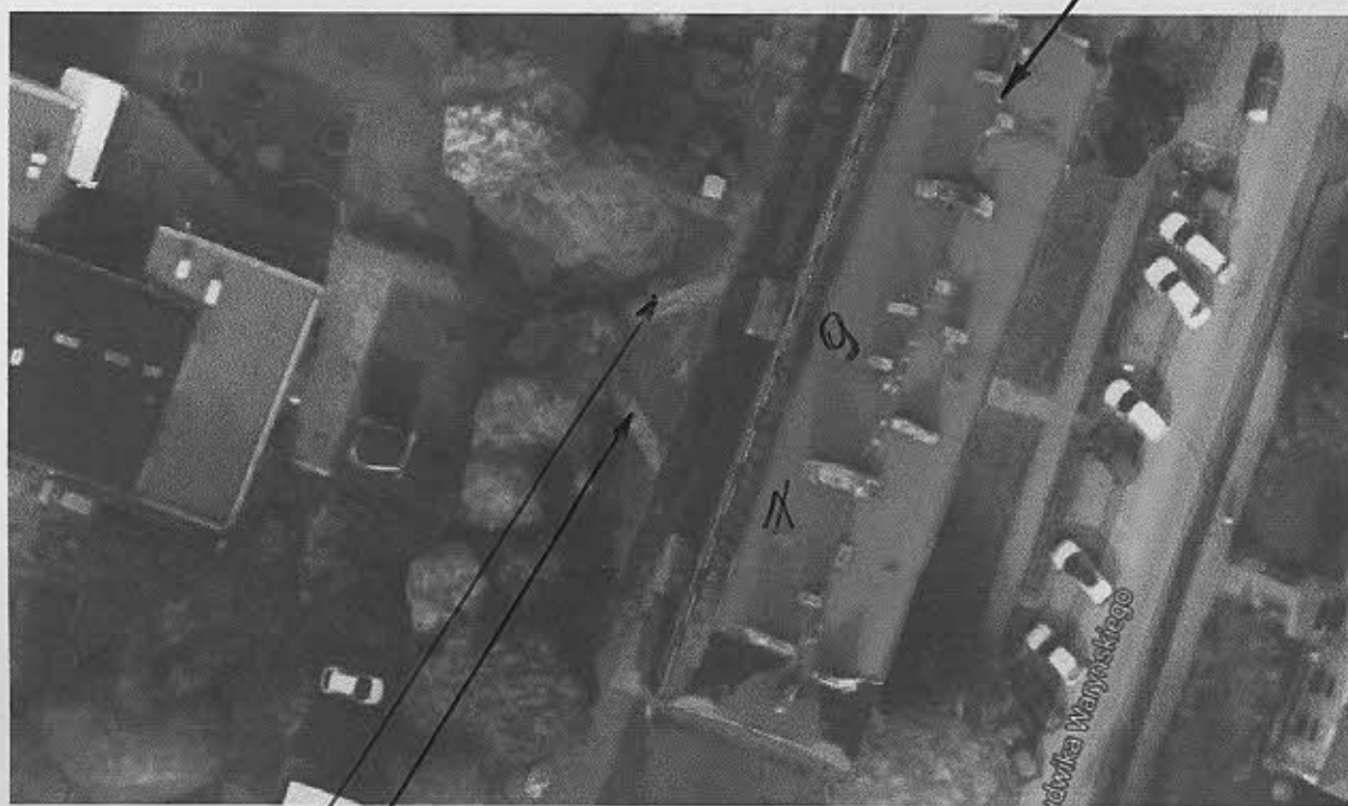
Chodnik do remontu
