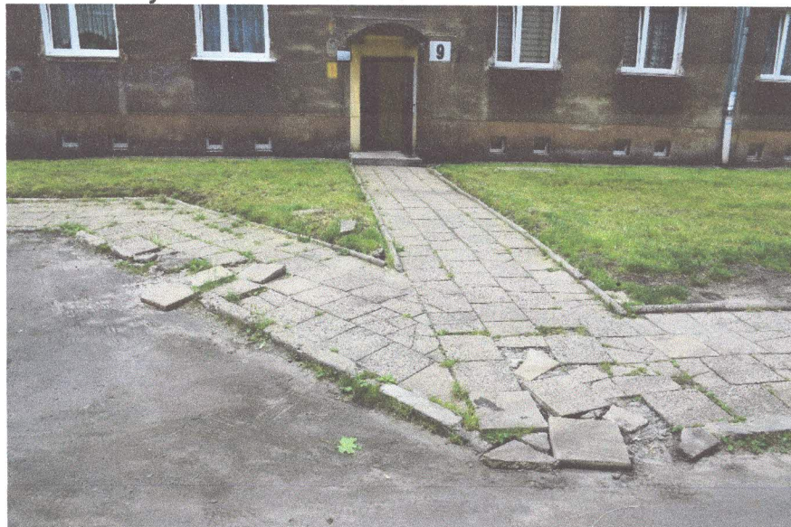
e- Wzdłuż budynku ul. Tuwima 7-9
