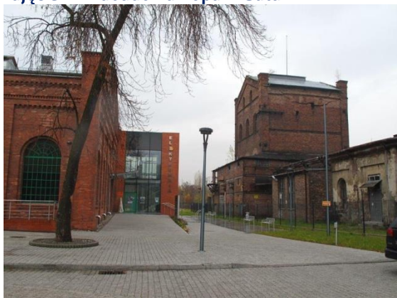
Zdjęcie 20. Zabudowa Kopalni Saturn
