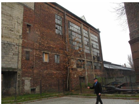
Zdjęcie 18. Zabudowa Kopalni Saturn
