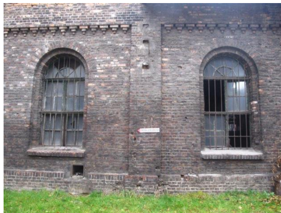
Zdjęcie 17. Zabudowa Kopalni Saturn
