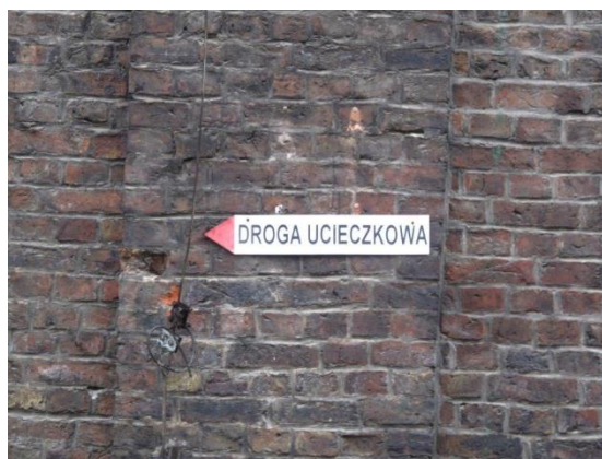
Zdjęcie 19. Zabudowa Kopalni Saturn
