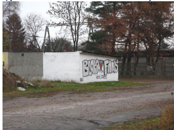
Zdjęcie 11. Garaże zlokalizowane w dzielnicy
