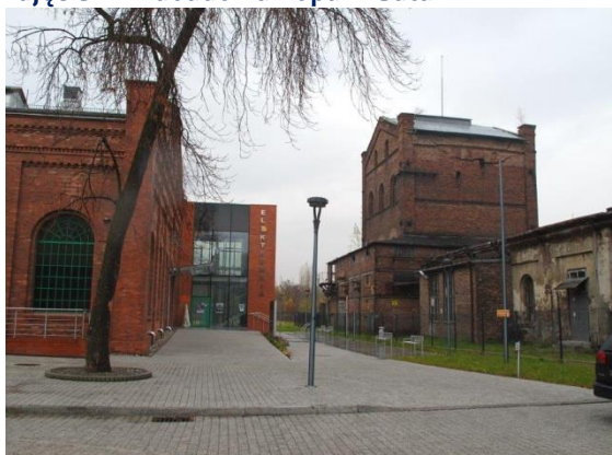
Zdjęcie 20. Zabudowa Kopalni Saturn
