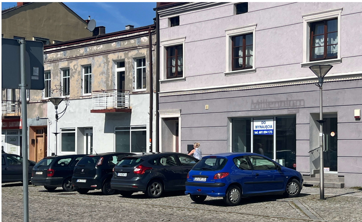
Rysunek 5. Kamienice przy Rynku – budynki wymagające remontu, pustostany.
