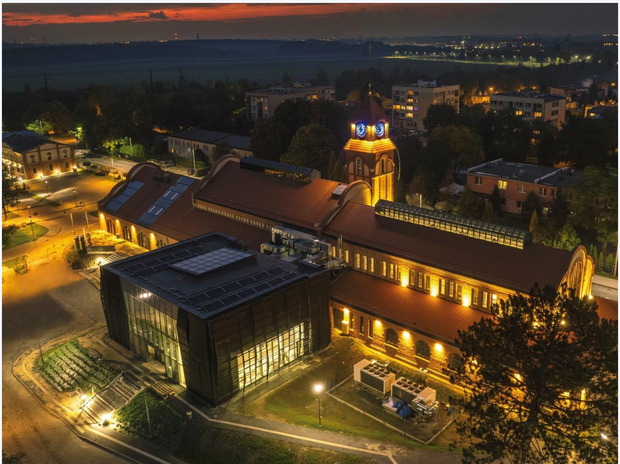
Zdjęcie 1. Widok na bryłę zrewitalizowanej Cechowni dawnej KWK Saturn
