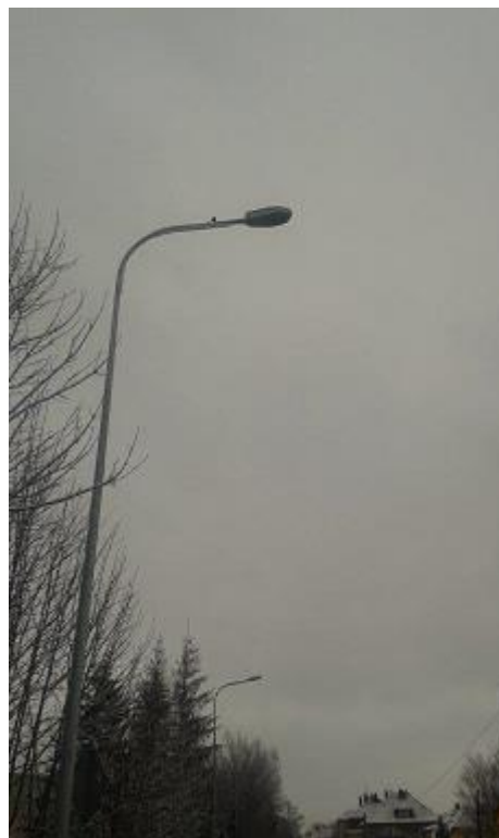
Przykład montażu oświetlenia na linii kablowej na słupach stalowych
