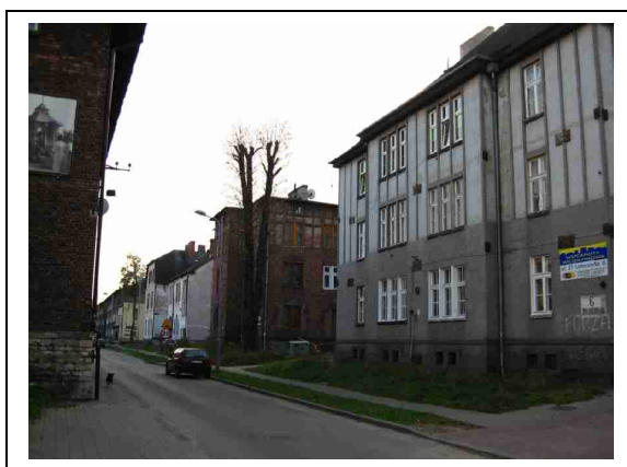
Zdjęcia 5 i 6. Zdegradowane budynki w obszarze Saturn
