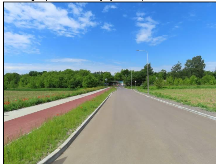
Fot. 8 Droga w północno-zachodniej części obszaru, widok w kierunku zachodnim
